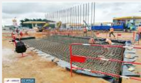
Avancement de la route de Dabou
