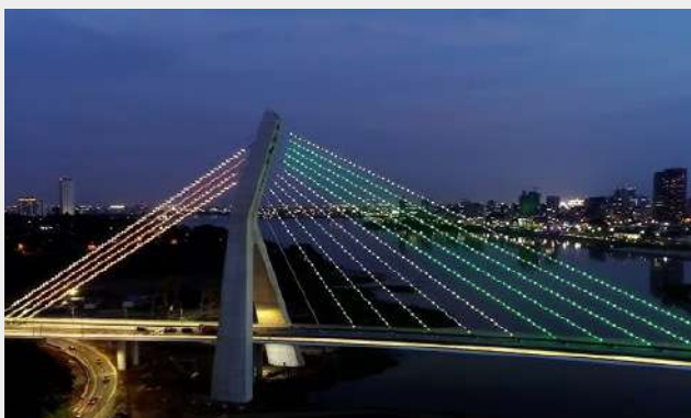
Une vue du pont de Cocody en construction sur la baie de Cocody
