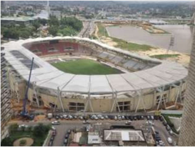
Stade Félix Houphouët Boigny d'Abidjan en cours de réhabilitation
