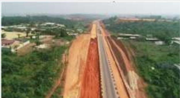
Avancement de la route de la prison civile
