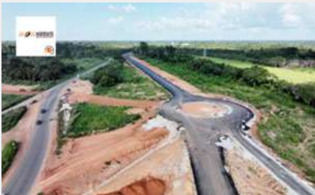
Travaux de construction de l'autoroute Yamoussoukro-Bouaké : Tronçon Tiébissou-Bouaké
