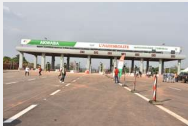
Poste à péage de la section Yamoussoukro – Tiébissou
