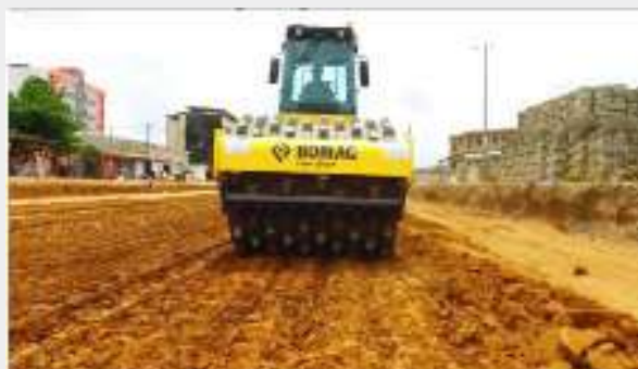
Avancement du prolongement du boulevard Latrille
